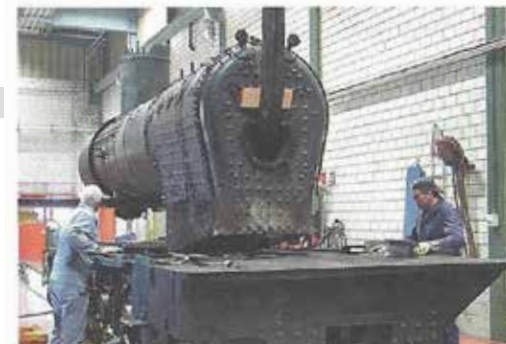
Der alte Kessel wird ausgebaut
