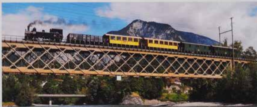
Auf der Rückfahrt vom 7. September ist die Probefahrt auf der Reichenauer Hinterrheinbrücke festgehalten.
