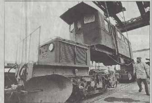
Die aus Frankreich in drei Teilen zurückgekehrte Lok 182 wird in Landquart wieder zusammengesetzt. (Foto Tibert Keller)
