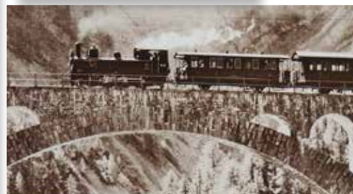
... auf der Landwasserbrücke bei Wiesen, hier festgehalten wie wenn es eine der ersten Fahrten dieser Lok überhaupt gewesen wäre ...
