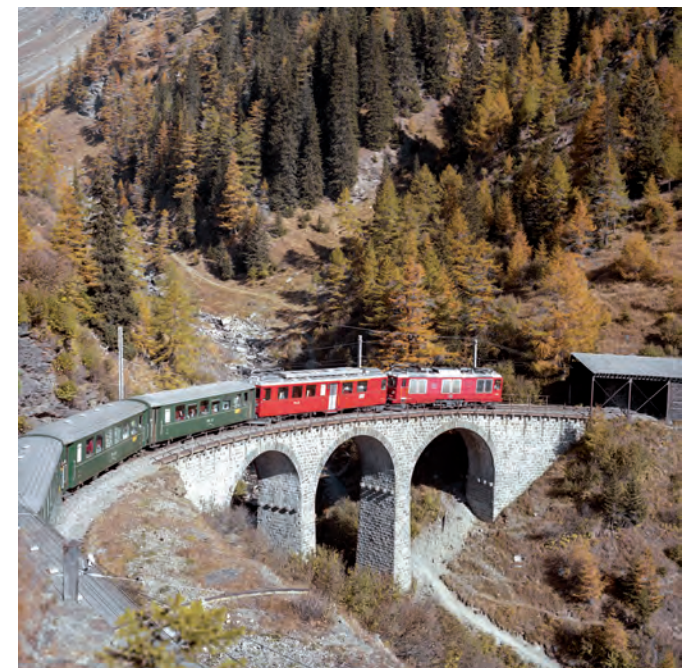
Der Beginn einer Erfolgsgeschichte: Der Bernina Express in der Urversion mit grünen EW I auf dem Pila Viadukt zwischen Alp Grüm und Cavaglia in den 1970er-Jahren.
