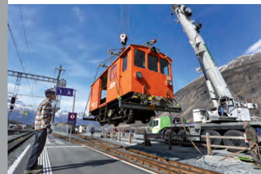
In der Luft: Am frühen Nachmittag hob ein Pneuroman den 13 Tonnen schweren Gepäcktriebwagen definitiv vom RhB-Netz.
